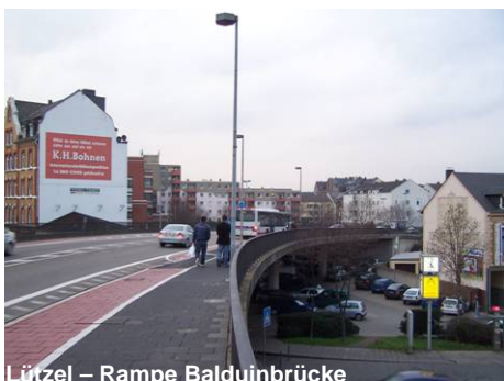
Lützel – Rampe Balduinbrücke
