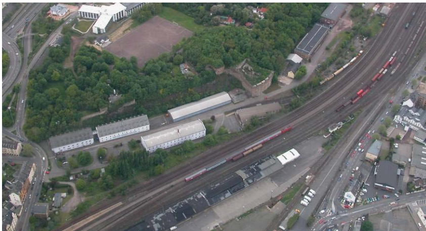
Blick von Osten über das Gelände der ehemaligen Standortverwaltung der Bundeswehr in Lützel
