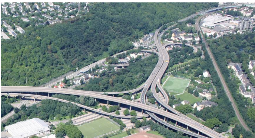
Blick von Südosten über den „ Stadteingang Süd “
