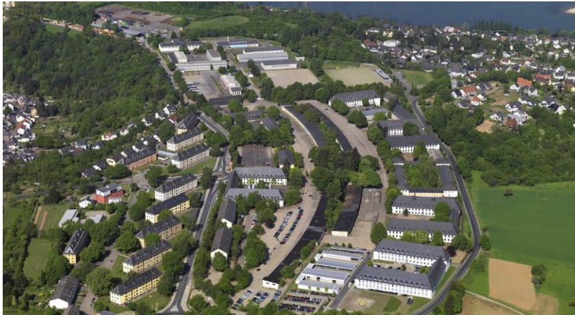
Blick von Osten über die Fritsch-Kaserne
