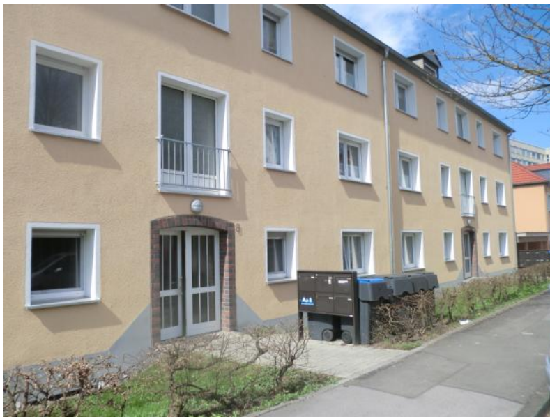
Abbildung 36:Seniorenwohngemeinschaft Arnsberg - Gebäude
