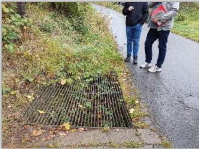
Beispiel Layer Bergweg: Optimierung vorhandener Einläufe in Bezug zur Abflussaufnahme
