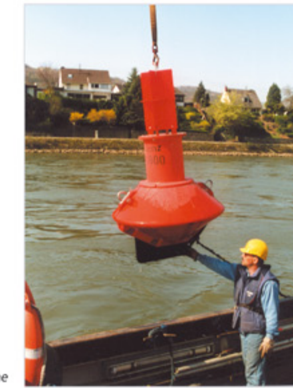
Bild rechts: Auslegen einer Fahrrinntonne
