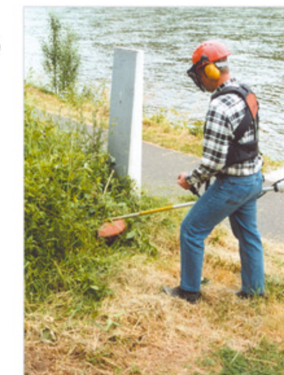
Bild rechts: Unterhaltungsarbeiten an der Uferböschung
