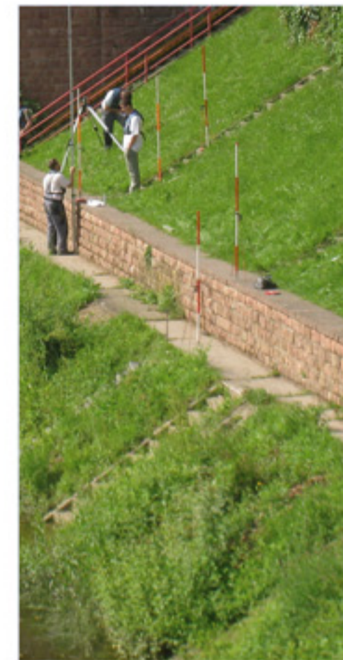
Bild oben: Vermessungsarbeiten
