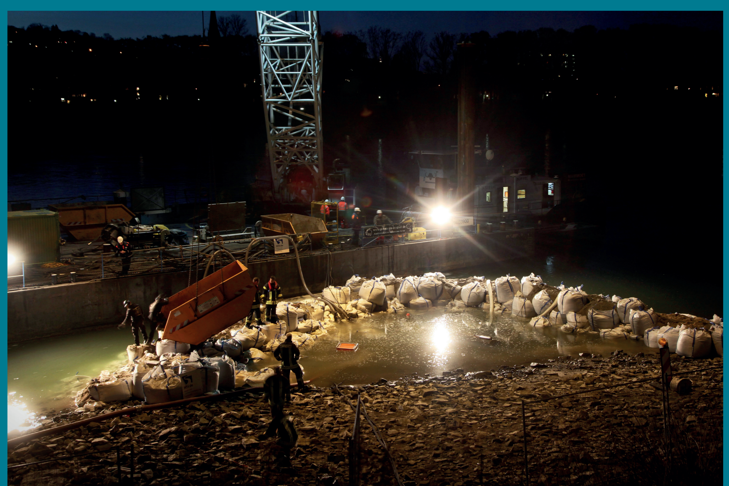
Um die Luftmine baute das Wasser- und Schifffahrtsamt Bingen einen Deich aus rund 350 tonnenschweren Sandsäcken.
