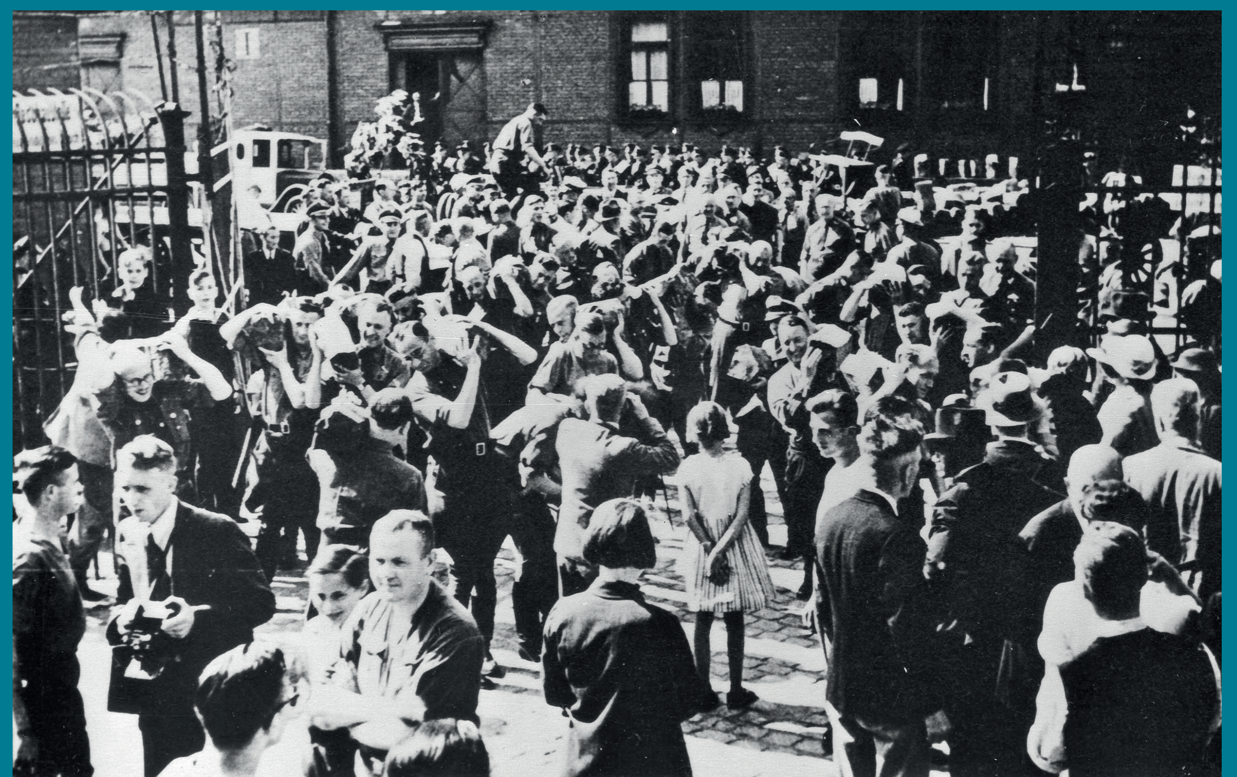
Der Bau der Thingstätte am Schloss ist ein Beispiel für die Inszenierung der Volksgemeinschaft. In eingeteilten Schichten schleppten die Koblenzer 1934 Steine vom Moselwerft zur Baustelle. Stadtarchiv Koblenz FA 4,24 Nr. 3 Bild 133
