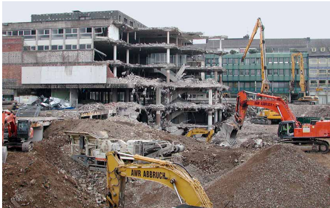
Die Abrissarbeiten sind in vollem Gange, September 2010
