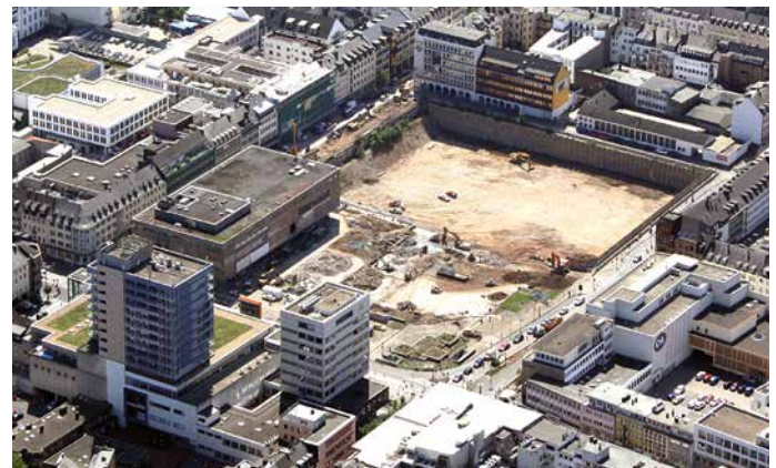
Start der Rückbauarbeiten, August 2010
