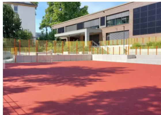
Der Schulhof der Freiherr-von-Stein-Grundschule mit 1.100 m 3 Retentionsraum (Stadt Koblenz, Philipp Apostel)
