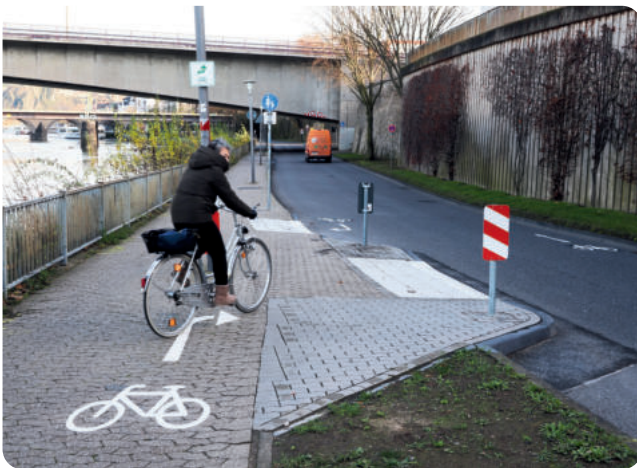
Der Übergang vom und zum Peter-Altmeier-Ufer am Leinpfad an der Mosel wurde so umgestaltet, dass der Radverkehr durch Einengung der Fahrbahn selbsterklärend und sicherer geführt wird.
