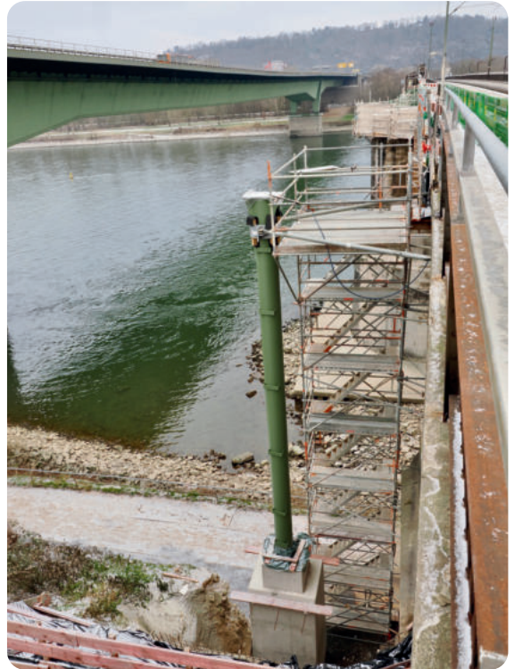
Stützpfiler aus Stahl mit Betonfundament für die neue Vorlandbrücke.
