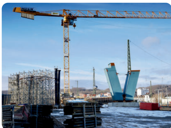
Die V-Pfeiler und die Stützpfeiler für den geplanten Geh- und Radweg sind beidseits bereits deutlich sichtbar.
