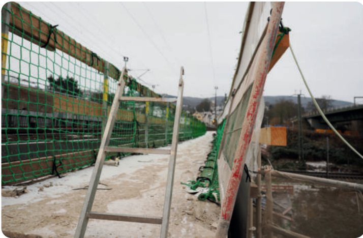
Der noch bestehende alte Weg wird abgerissen, um Platz für die neue Verbindung zwischen "Festland" und Brücke zu schaffen.
