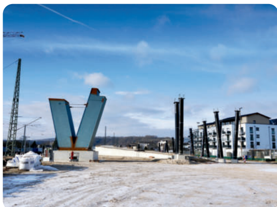
Die V-Pfeiler und die Stützpfeiler für den geplanten Geh- und Radweg sind beidseits bereits deutlich sichtbar.
