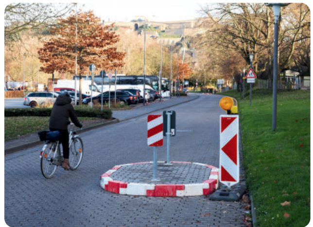
Mobile Randsteine sorgen dafür, dass die zulässige Höchstgeschwindigkeit von 30 km/h eingehalten wird. Da diese Elemente jedoch auch den Radverkehr ausbremsen, werden sie stellenweise durch Bodenschwellen ersetzt.
