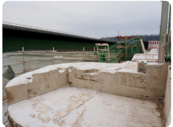
Der gemauerte Bestandspfeiler wird derzeit für die Aufnahme der neuen Vorlandbrücke vorbereitet.
