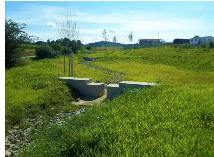
Retentionskaskade mit Retentionsmulden und Drosselementen in Winnenden Adelsbach (Quelle: Henning Larsen)
