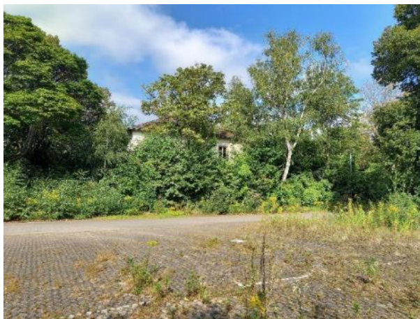
Südwestlich Gebäude U3
