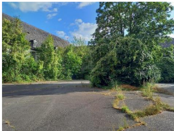
Innenhof des Gebäudes U6 (östlich der zentralen Zufahrt)
