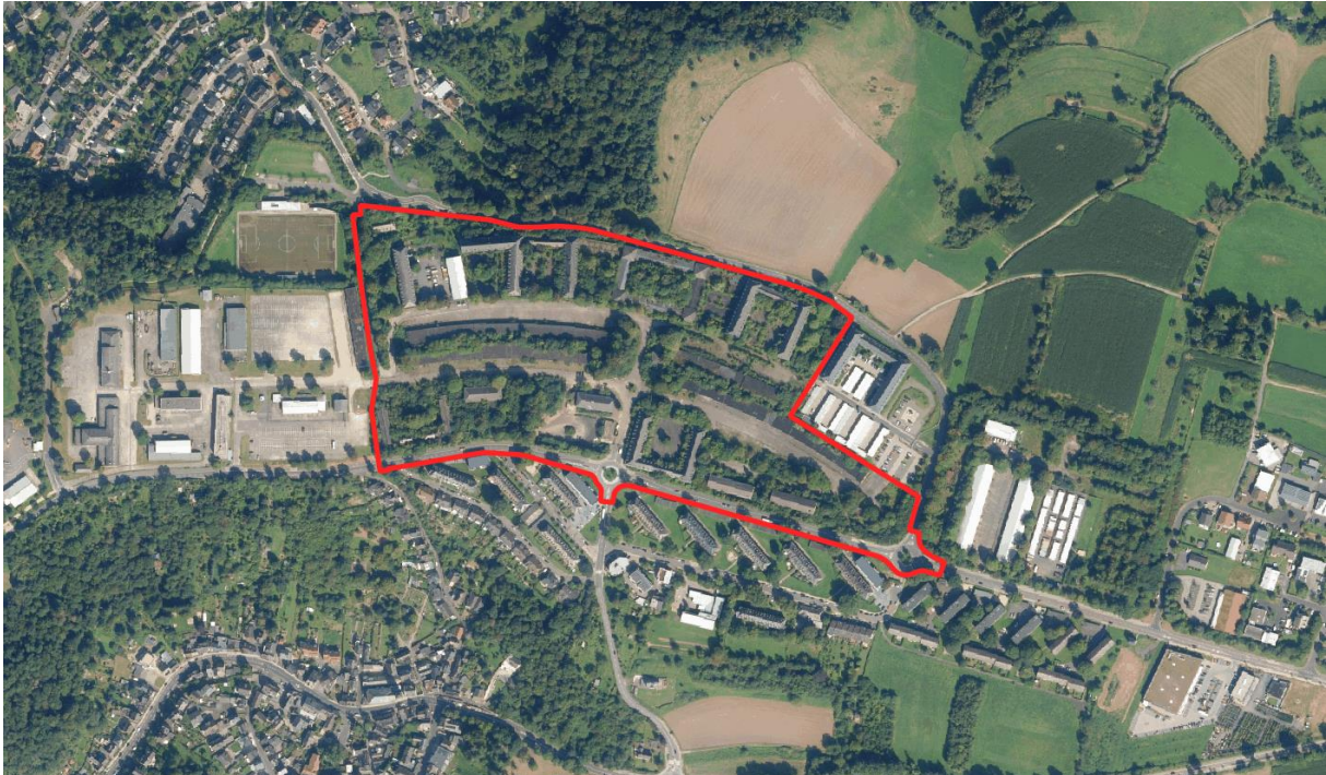
Abbildung 2: Überblick über das Bebauungsplangebiet
